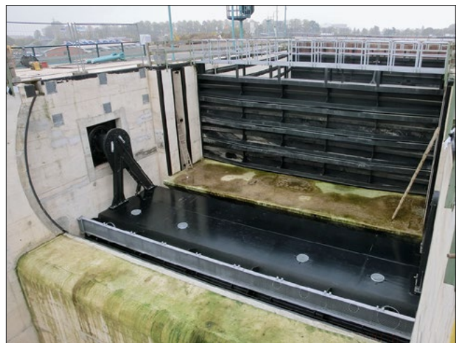
Bild 6: Dammbalkenverschluss vor dem Obertor
