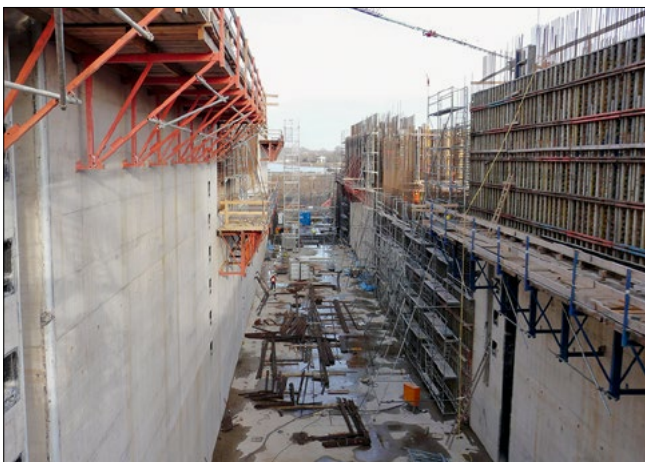
Bild 14: Betonarbeiten Schleusenammer
