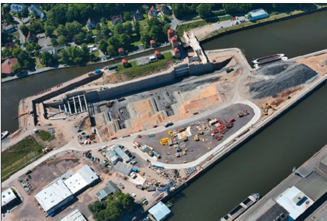
Bild 11: Luftbild der Baugrube
