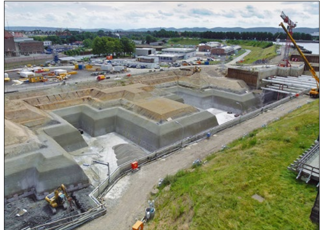
Bild 12: Blick auf die östliche Baugrubenböschung
